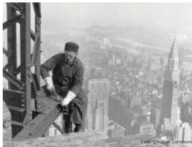
Trabajador en el Empire State Building a principios de 1930 Foto: Creative Commons
