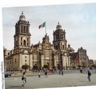
La Catedral Metropolitana de México fue edificada sobre el Templo de Quetzacóatl.
