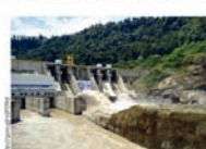
La construcción de centrales hidroeléctricas reduce la dependencia de energía importada. Imagen de la central hidroeléctrica Marabalturo en Imbabura.
