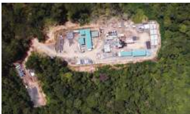
Pozos de exploración del campo 17, Pastaza Foto: Licencia C.C.
