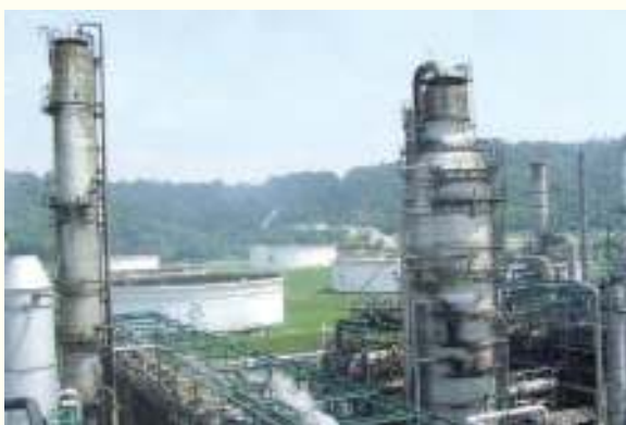
Refinería de petróleo en Esmeraldas Foto: Petroecuador
