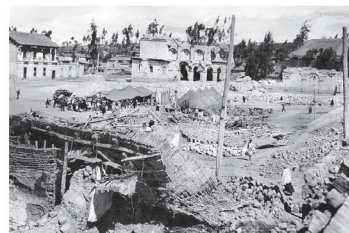
Terremoto de Ambato, 1949
